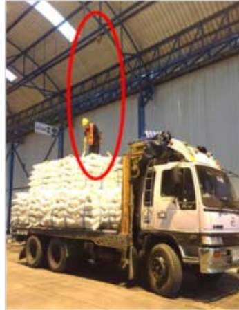
ติดตั้ง Safety Sling สำหรับ ใช้กับพนักงานขับรถบรรทุก
